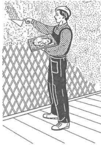
Рис. 3.3. Накидання штукатурного розчину кельмою з сокола на стіну
